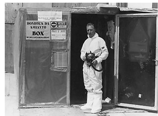
Asbestsanierungen dürfen nur mit einem Schutzanzug und Atemmaske ausgeführt werden.
